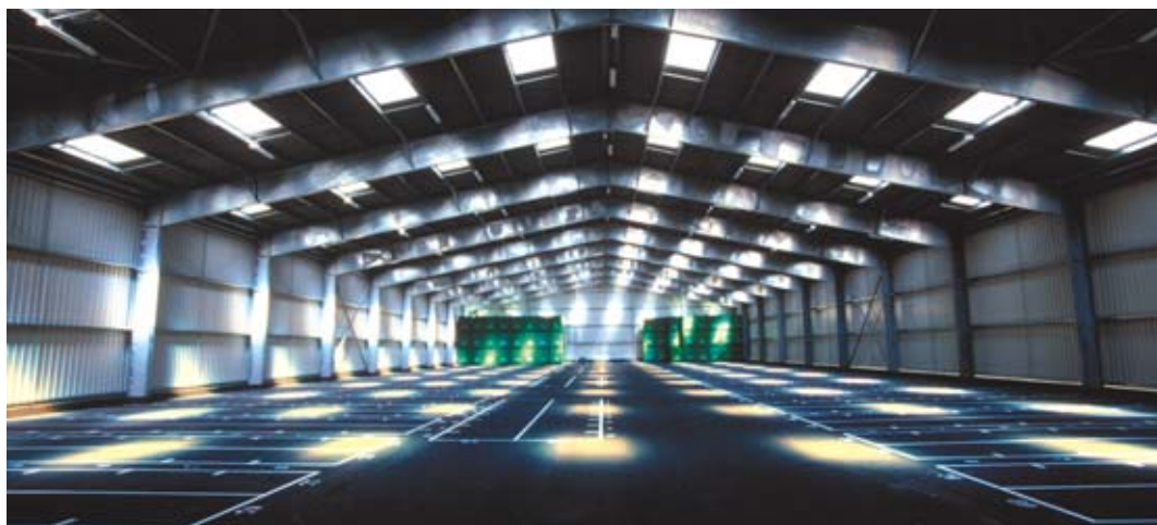
Parc d'entreposage de conteneurs d'oxyde d'uranium appauvri ( U_3O_8 ) sur le site industriel de Bessines (Haute-Vienne).
